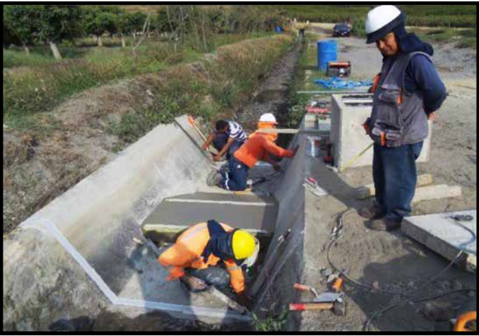
Ejecución de la partida sellado de juntas de dilatación con material elastomérico, Canal 29.1.1.7 - JUSHM IRCHIM. Región Áncash.
