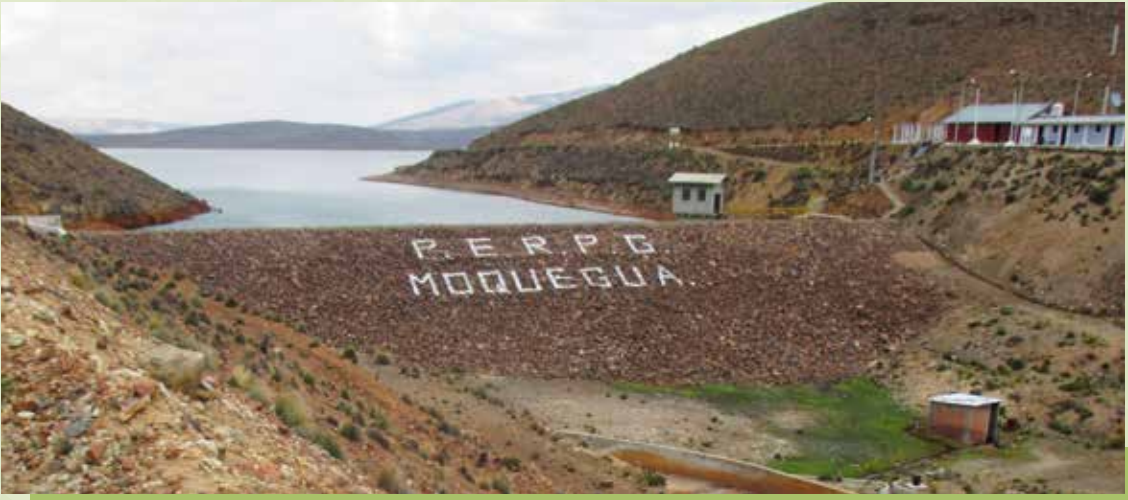
Presa Pasto Grande
