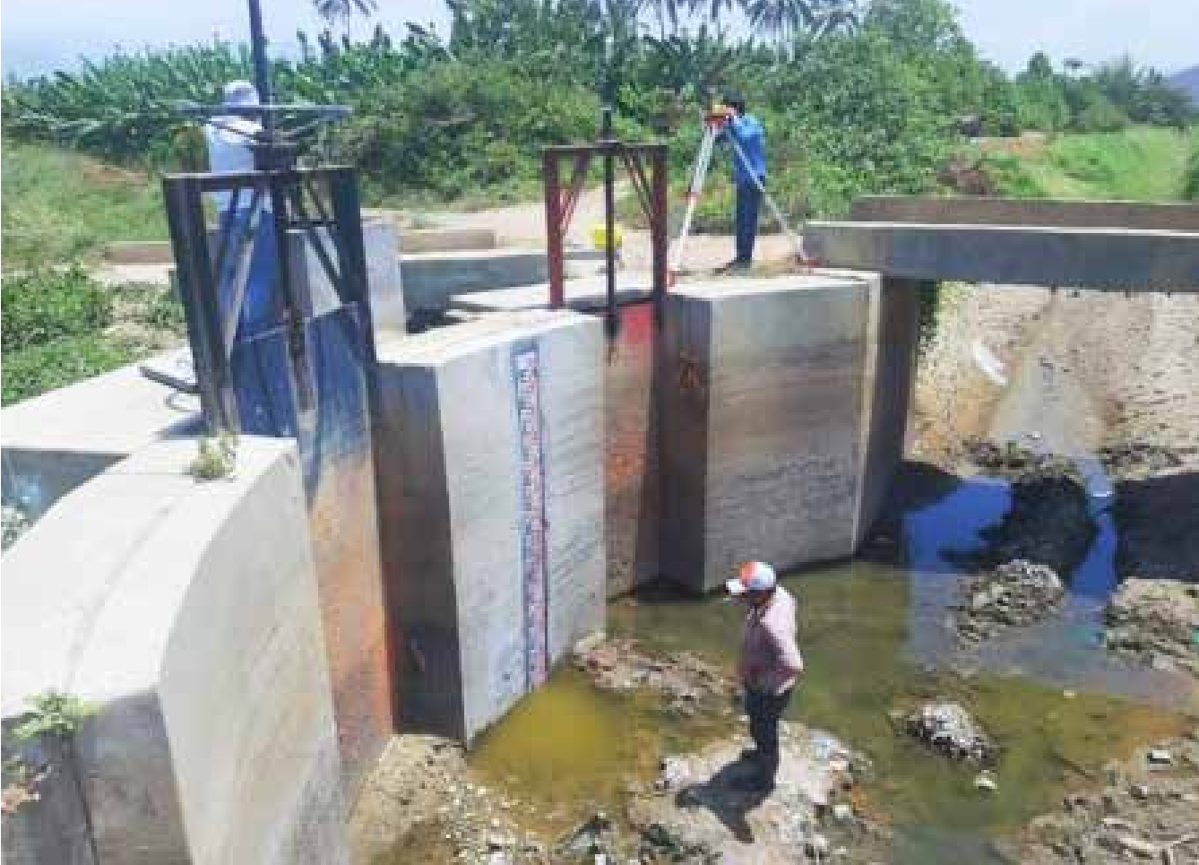
Instalación regla limnimétrica - L1 Santa Julia SHM Alto Piura.
