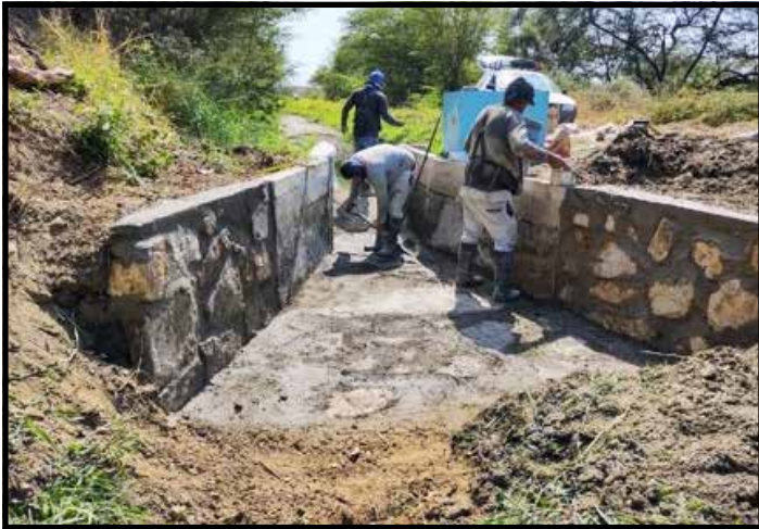
Mampostería de piedra - L2T 23+800 SHM San Lorenzo.
