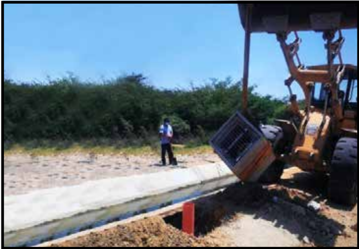
Traslado e instalación de caja de alojamiento - El Arenal SHM Chira.
