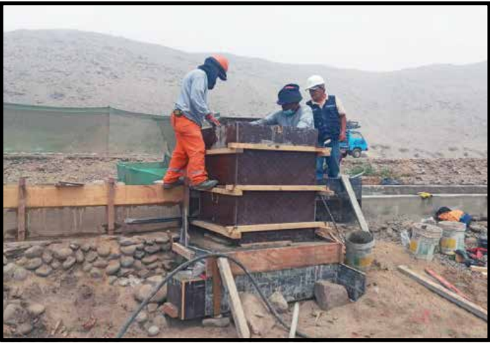
Vaciado de concreto f'c=210 Kg/cm² para caja de alojamiento de sensor - CD Concón en el SHM- Chillón. Región Lima.
