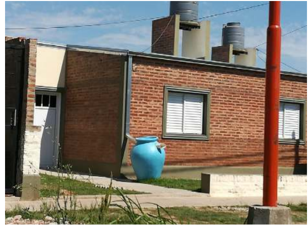
Imagen 10: Retardador pluvial en vivienda, Santa Fe, Argentina. Marta Paris.
