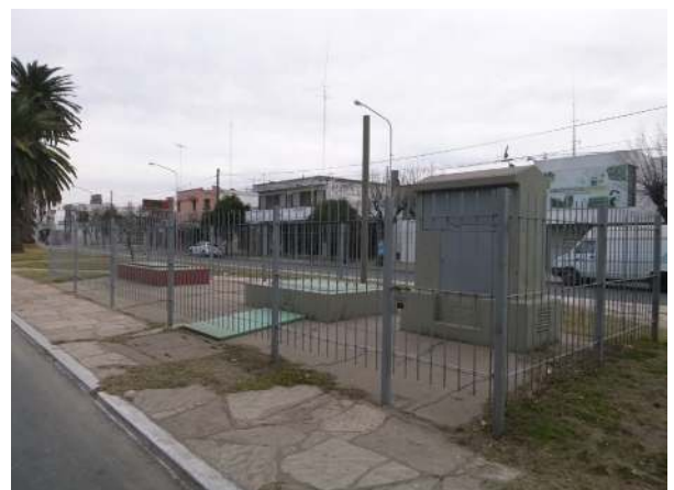
Imagen 2: Perímetro de protección en pozo de abastecimiento de agua en zona urbana, Villa María, Córdoba, Argentina. Marta Paris o .
