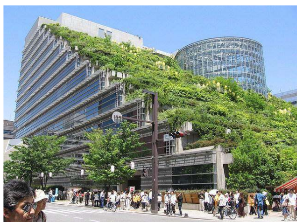
Imagen 8: Uso de cubiertas verdes en infraestructura.
